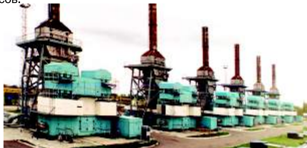
ГПА-Ц-6,3С с газотурбинным двигателем ДТ71 на КС Диканька, Украина
