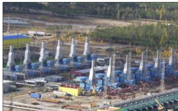
Агрегаты ГПА-Ц-16С с двигателем UGT 15000 на компрессорной станции "Комсомольская", Россия
