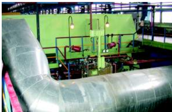
Двигатель ДН70Л в составе модернизированного агрегата ГТК-10-4 на КС Кировоградская, Украина
